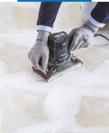
Szlifowanie powierzchni wyrównanej z użyciem Planiprep 4 LVT
