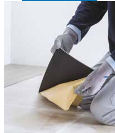
Usunięcie folii ochronnej z samoprzylepnego panela LVT
