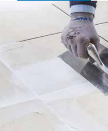
Wyrównywanie powierzchni płytek i wypełnianie spoin z użyciem Planiprep 4 LVT
