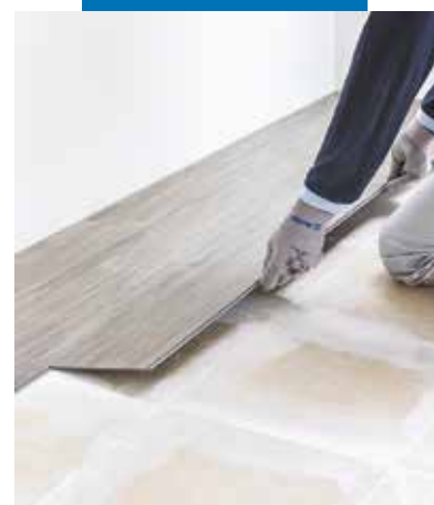
Układanie paneli LVT montowanych na klik na posadzce ceramicznej wyrównanej z użyciem Planiprep 4 LVT
